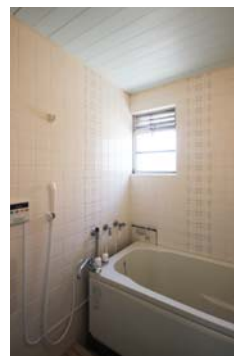
高温足し湯機能付浴槽
