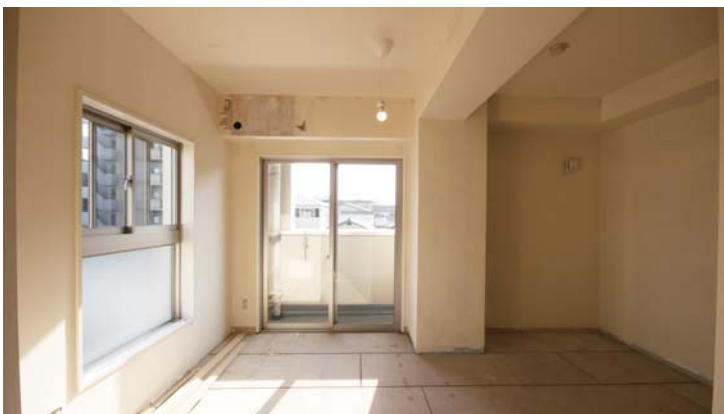
□内装前の室内
